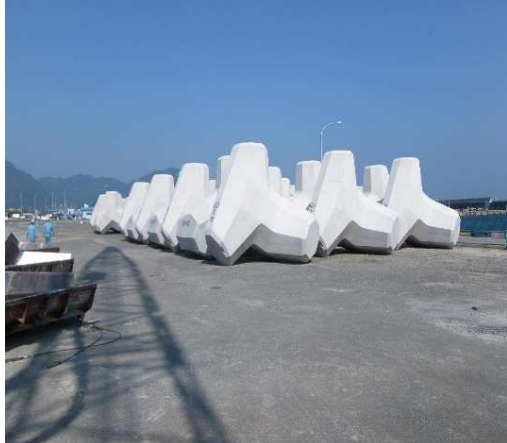
消波ブロック製作工事
